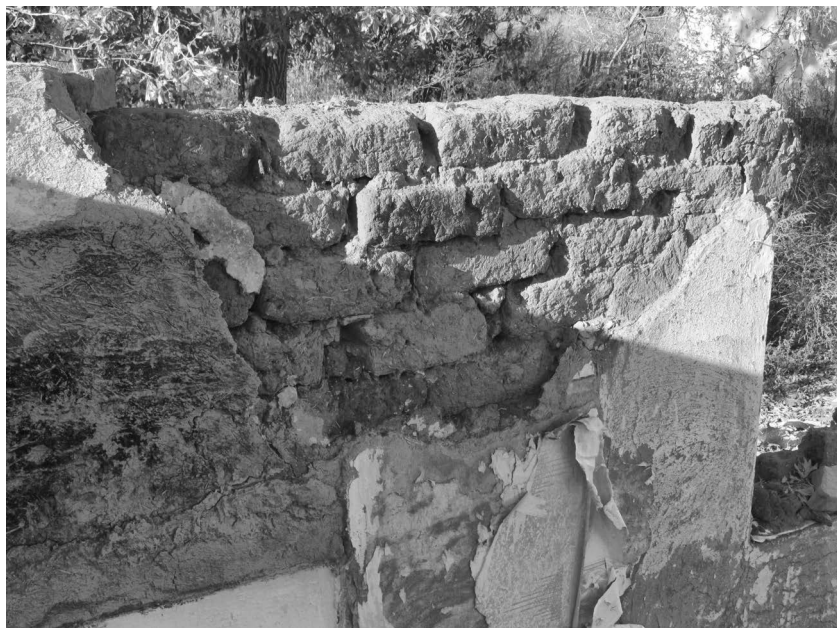
Рис. 22. Кладка стены дома из саманного кирпича. Алтайский край, Благовещенский район, с. Яготино. Материалы ИЭЭ 2013 г.
