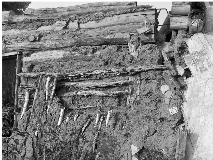
Рис. 19. Фрагмент стены хаты. Турлучная техника. Алтайский край, Панкрушихинский район, с. Зятьково. Материалы ИЭЭ 2012 г.
