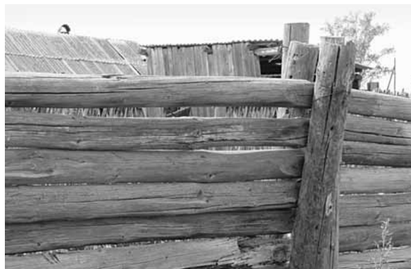
Рис. 12. Фрагмент забора из бревен с креплением «в столб». Село Усть-Кормиха, Волчихинский р-н.
