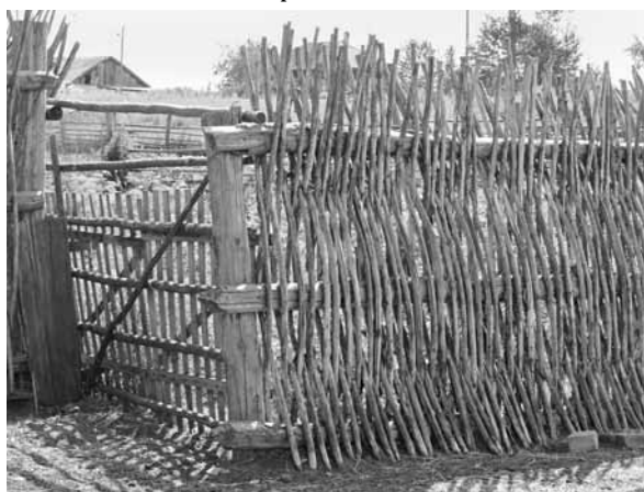
Рис. 15. Фрагмент плетня. Село Усть-Кормиха Волчихинского р-на, 2011 г.
