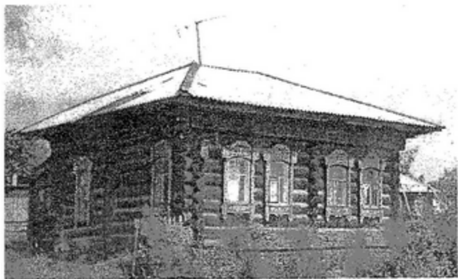
Фото 8. С. Залесово, ул. Больнич- ная, 24. Об- щий вид
